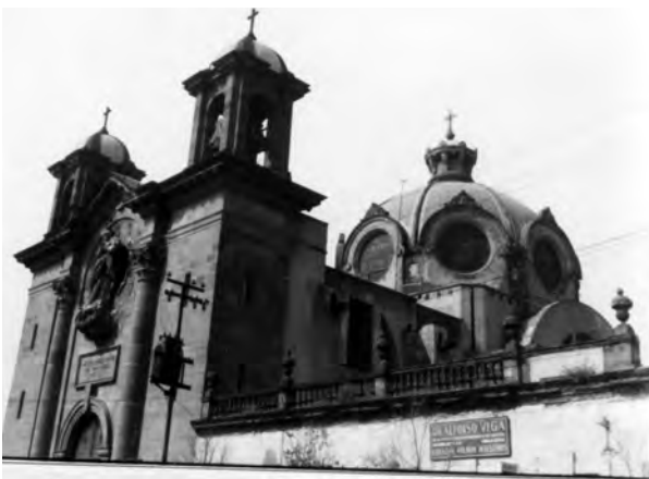
Figura 18. En esta fotografía, donde se observa la parte superior del templo y de las viviendas, podemos comprobar que el muro de la fachada del panteón es la misma, por el remate con su balastrada. Se observa un anuncio del doctor Alfonso Vega, cuyas especialidades eran el corazón, el pulmón y los intestinos. Fototeca Constantino Reyes-Valerio-CNMH.
