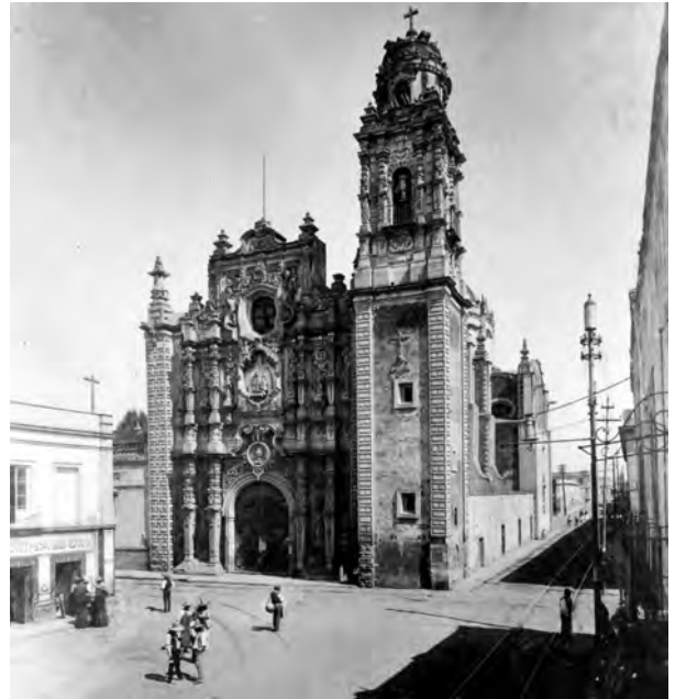
Figura 7. Fachada del templo cuando el nivel de la calle permitía un acceso franco al templo y a las vías de acceso. Fotografía de Guillermo Kalha. Fototeca Constantino Reyes Valerio, CNMHINAH, núm. de catálogo: DLXXIV-85.
