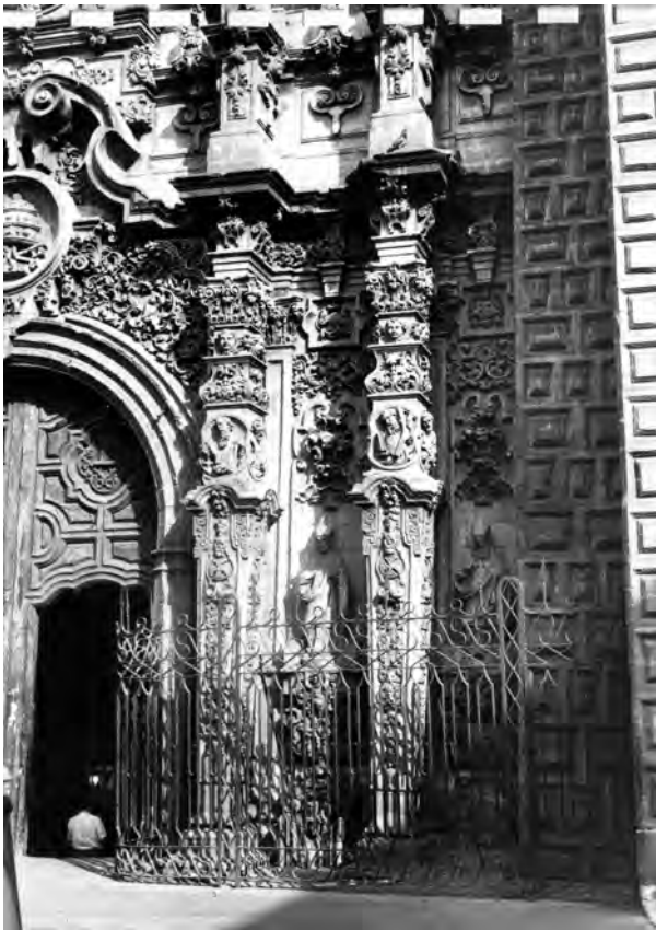
Figura 6. Detalle en la fachada principal del templo. Los estípites o soportes que cubren la función de las columnas fueron utilizados en México a partir del primer tercio del siglo XVIII y se popularizaron después de la construcción del Retablo de los reyes de Jerónimo de Balbás en la Catedral de México. Por la persona que se observa a través de la puerta abierta podemos apreciar el desnivel del suelo al interior del templo. Fotografía de Juan Valdivia Aranda, 24 de noviembre de 1971. Fototeca Constantino Reyes Valerio, CNMHNAH, núm. de catálogo: DCCIV-85.
