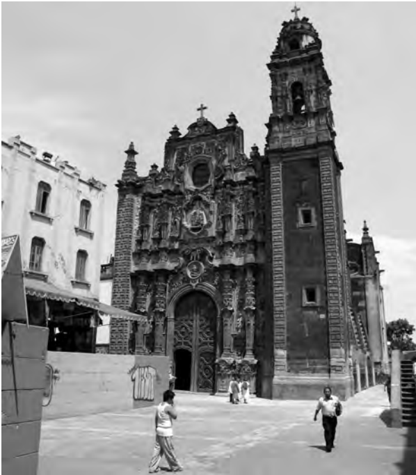
Figura 20. Fachada de la Santísima Trinidad, cuyas rampas exclusivamente dan acceso al templo, por lo que impiden la comunicación original de las vías de circulación. Fotografía de Nuria Salazar Simarro, 31 de marzo de 2009.
